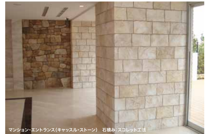
マンション・エントランス(キャッスル・ストーン) 右側柱:スコレット工法
