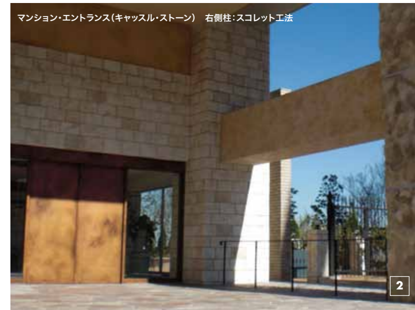
マンション・エントランス(キャッスル・ストーン) 石積み:スコレット工法
